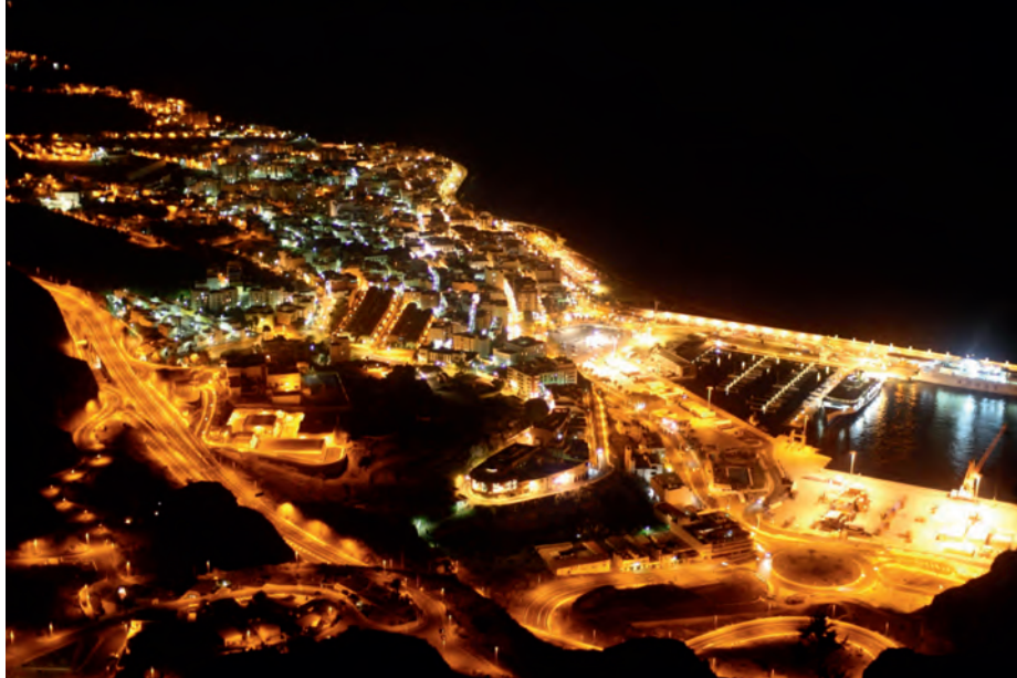
Abb. 4.2 Straßen mit abgeschirmter Beleuchtung in Santa Cruz de La Palma
