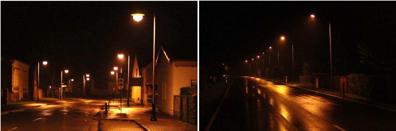
Abb. 15: Beleuchtung nach DIN. Geringer Leuchtenabstand, Leuchten auf beiden Straßenseiten, Beleuchtungsstärke 30 Lux, Halbkugelleuchten erhellen auch die Häuser und wirken blendend.
